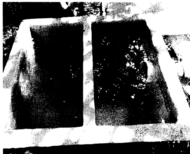
Imagen 2. Obra de control de caudal
