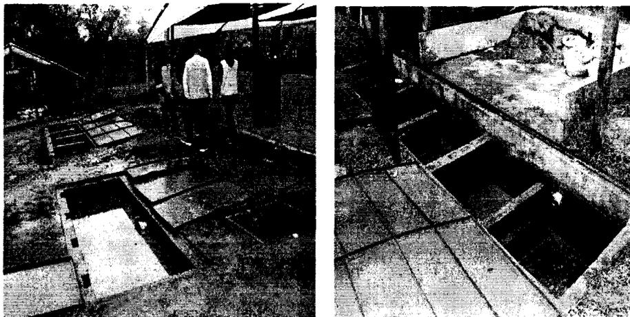
Fotografía # 3, Lugar donde está ubicado el sistema de tratamiento de las aguas residuales domésticas, tanque séptico.
