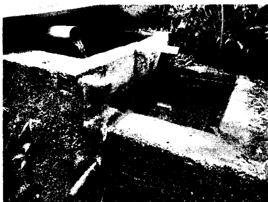
Imagen 1. Obra de captación y control de caudal. 1
