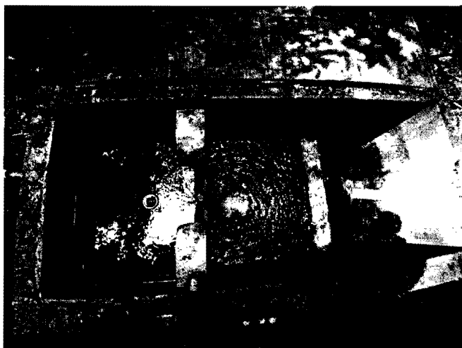
Fotografía 1 Obra de control de caudales fuente Camargo
