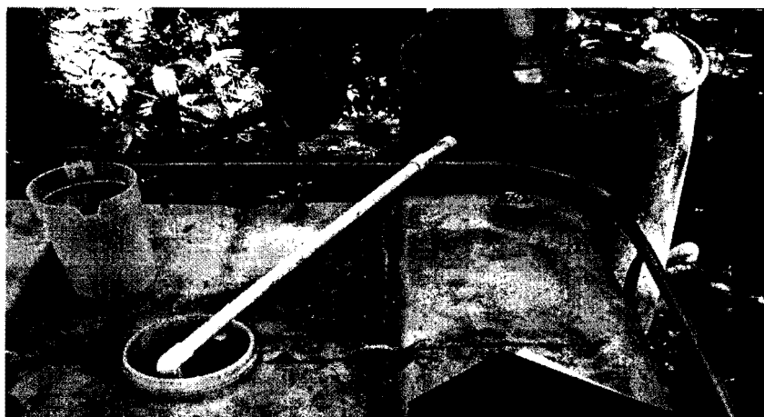
Fotografía 1 Tanques, obra de control de caudal.
