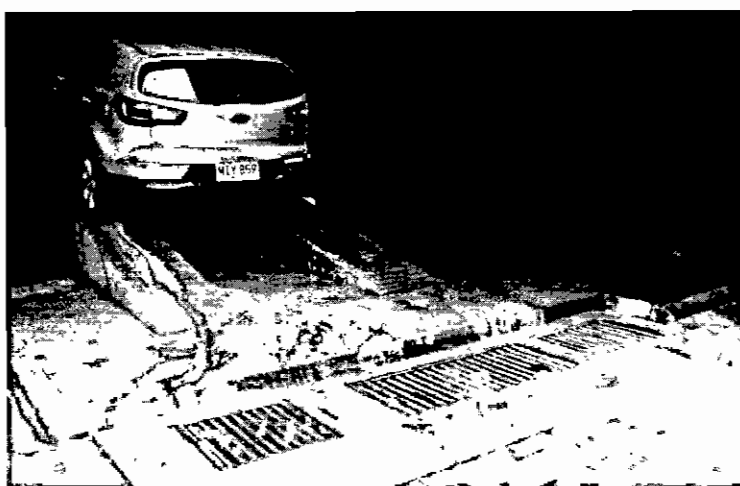
Fotografía # 2, Pre-sistema de tratamiento de aguas residuales no domésticas del lavadero Stop Car que consta de: un cárcamo, dos trampas de grasas, un sedimentador y una caja de inspección.
