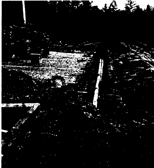
Fotografía 1. Conducción del sedimentador a los nuevos módulos del SRATND
