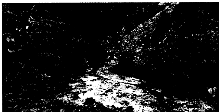
Figura 2. Fuente hídrica sin nombre. Material fino depositado en la margen derecha, caído y arrastrado hacia la fuente
