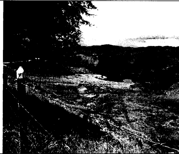
Foto 5. Se evidencia la intervención de la fuente hídrica con maquinaria pesada, el suelo removido se encuentra expuesto a la escorrentía superficial.
