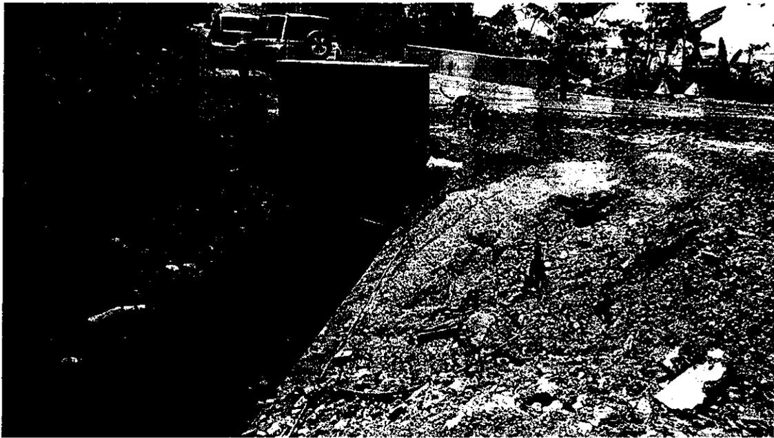
En el Box Couvert del Km 28+670, el cabezote de ingreso (ancho 1.4 m x alto 1.3 m) no cumple con la dimensiones autorizadas (3.0 m x 3.0 m), por lo que se hace necesario verificar hidráulicamente si las dimensiones actuales cumplen para el caudal del período de retomo de los 100 años. Este ya se encuentra construido en su totalidad.
