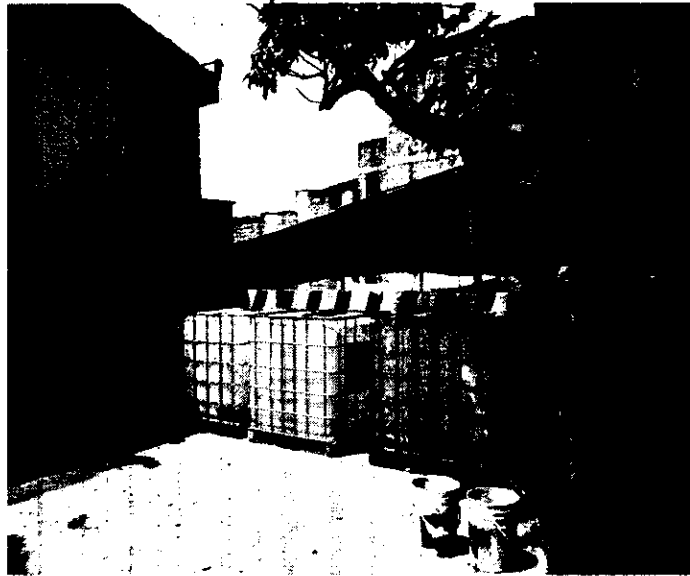
Existencia de 3 tanques de plástico para almacenamiento de aguas lluvias
