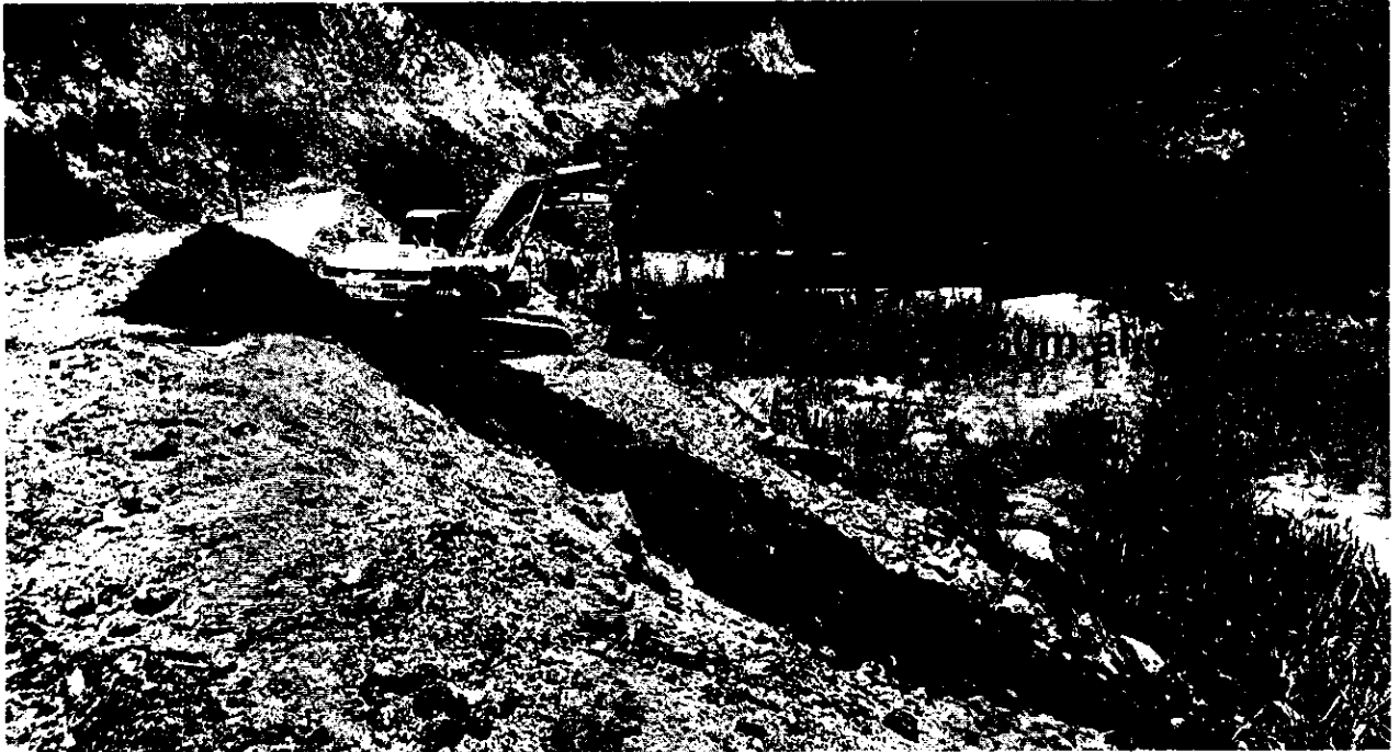
Construcción de trinchos y separación al río.
