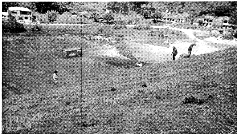
Fotografía No. 2: Trinchos colmatados, han superado su capacidad de contención.
