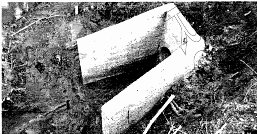
Figura 4. Obra de entrega en la quebrada Chachafruto
