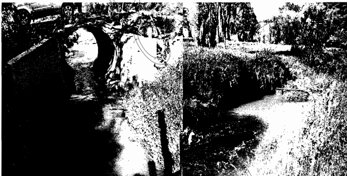
Foto 2 y 3 Paso para habilitar vía sobre Quebrada Chachafuto con tubería corrugada y en la otra foto se observa socavación de margen izquierda de la quebrada.
