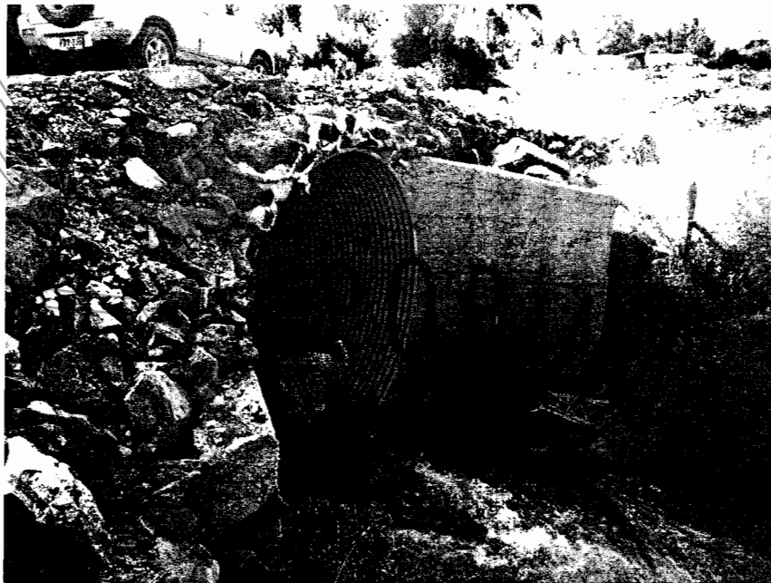
Foto 4. Obra hidráulica sobre quebrada Chachafruto
