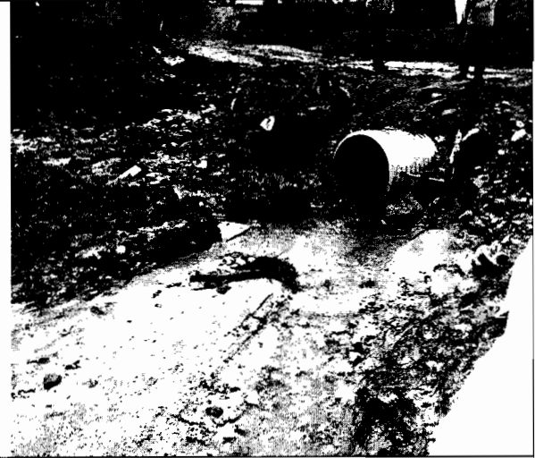
Imagen 10: Descarga de obra sobre la quebrada Chapinero
