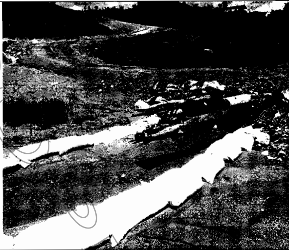
Imagen 9: Obra no autorizada para paso sobre la quebrada Chapinero
