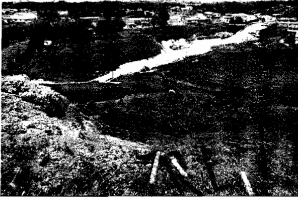
Imagen 5: Panorámica de la vía de acceso al proyecto y localización del cauce a intervenir. (2015)
