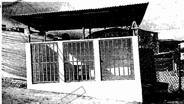
Fotografía No. 1 Zona de almacenamiento de residuos peligrosos
