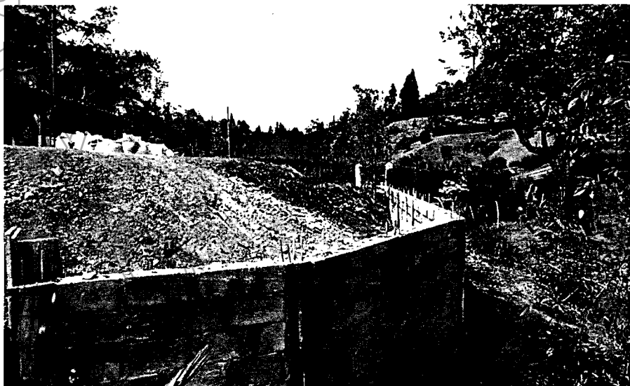
Figura 1. Muro conformado en la pata del talud
