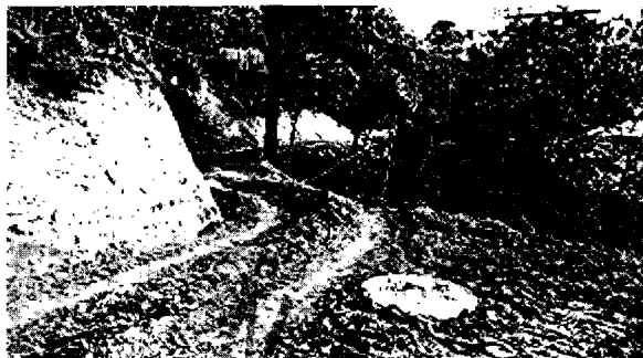
Tubería de 25" de diámetro distribuida sobre el eje de la vía
