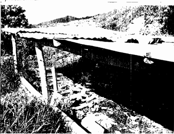
Foto 4. Caseta de orgánicos clausurada con residuos ordinarios en su interior."
