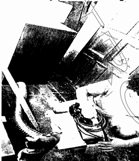
Fotografía No. 13. Extractor sin instalar
