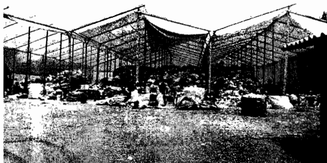
Zona de trabajo
