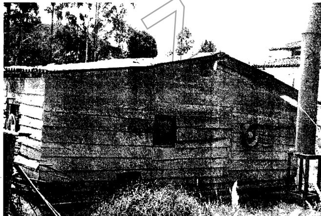
*Vista exterior de la ramada de de aplicación de sellador y pulimento (se observa la base de la chimenea y que los extractores laterales aun continúan instalados)*
