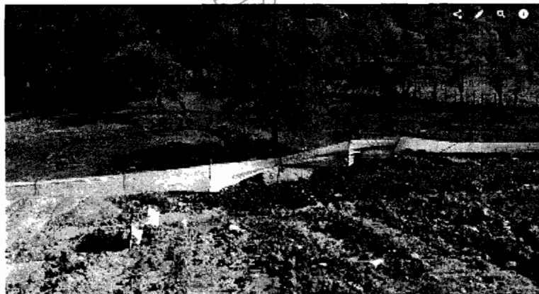
Ilustración 2- Pozo de sedimentación y filtros en la parte baja del predio
