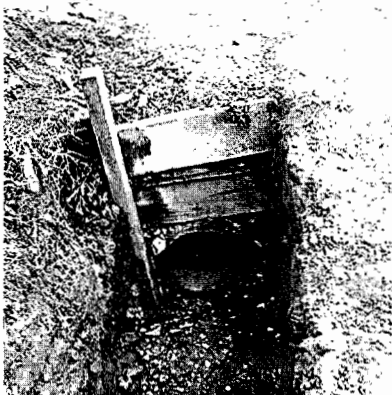
Obra transversal realizada
