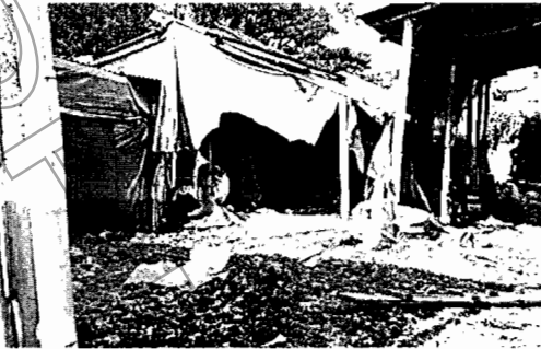
Bodega de almacenamiento sin pacas de algodón
