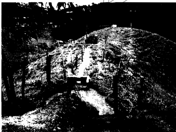
Canal de conducción hacia el tanque estercolero. Zanjas de conducción de excretas
