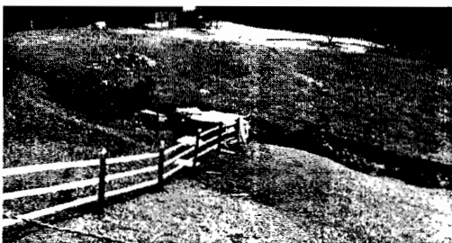
Canal artificial construido para desviar el caudal de la Quebrada La Gurupera
