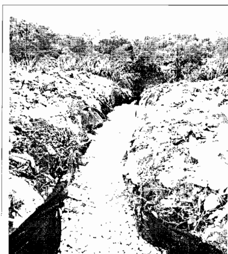
Foto 1. Adecuación de filtros horizontales
