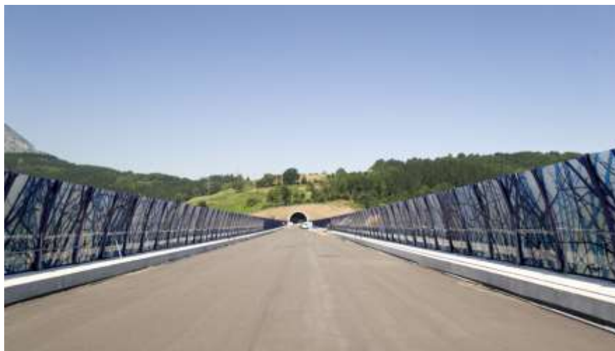
Figura 3. Pantalla acústica en vía de automotores.
