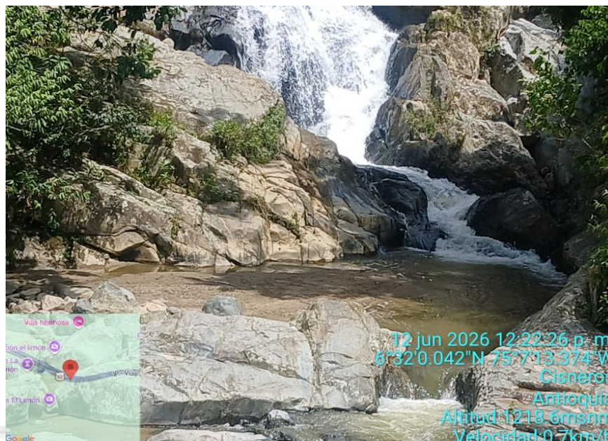
Fotografía 7. Charco “La Chorrera” colmatado
