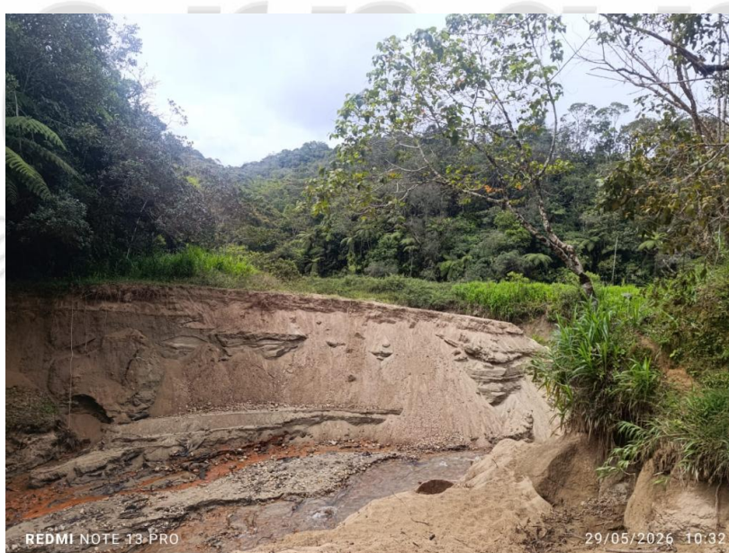
Fotografía 5. Zona aguas arriba de la captación Fuente: Cornare, Mayo 2026
