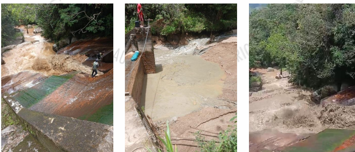
Fotografía 3. Apertura de la compuerta de la estructura de captación Fuente: Cornare, Julio 2026
