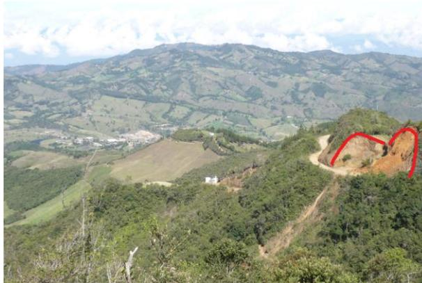
Foto 8. Deslizamiento asociado al corte de la vía veredal.
