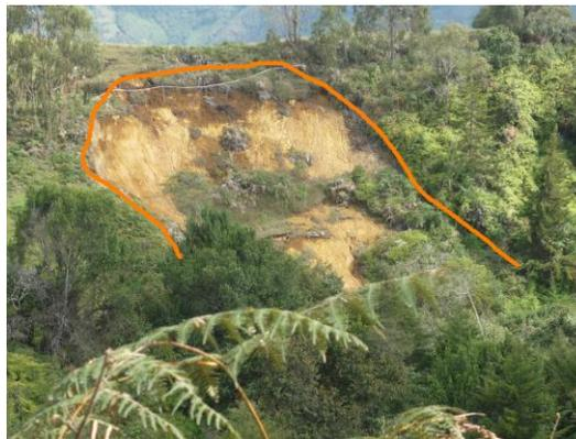
Foto 7. Deslizamiento que afecta un predio particular, observándose la una tubería de conducción de acueducto con fugas que posiblemente fue detonante de este evento.
