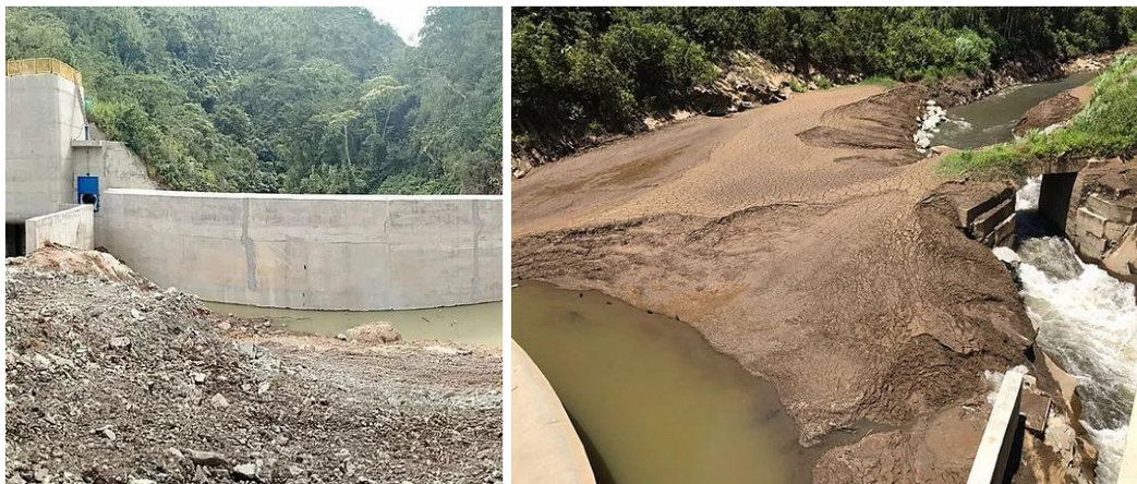
Figura 2-2. Colmatación pondaje PCH Morro Azul. Fuente: (ENGEO Engenharia e Geologia LTDA, 2016; Hidrológica Ingeniería, 2017)
