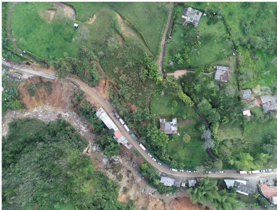
Imagen 1 Quebrada El Chocho, Municipio de Marinilla. Vía de orden departamental afectada por múltiples deslizamientos provocados por intensas lluvias.
