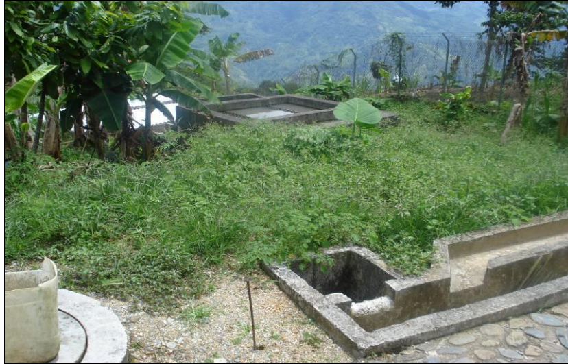
Foto 3. Planta de tratamiento de aguas residuales La Tripa o No. 1. Municipio de San Francisco.
