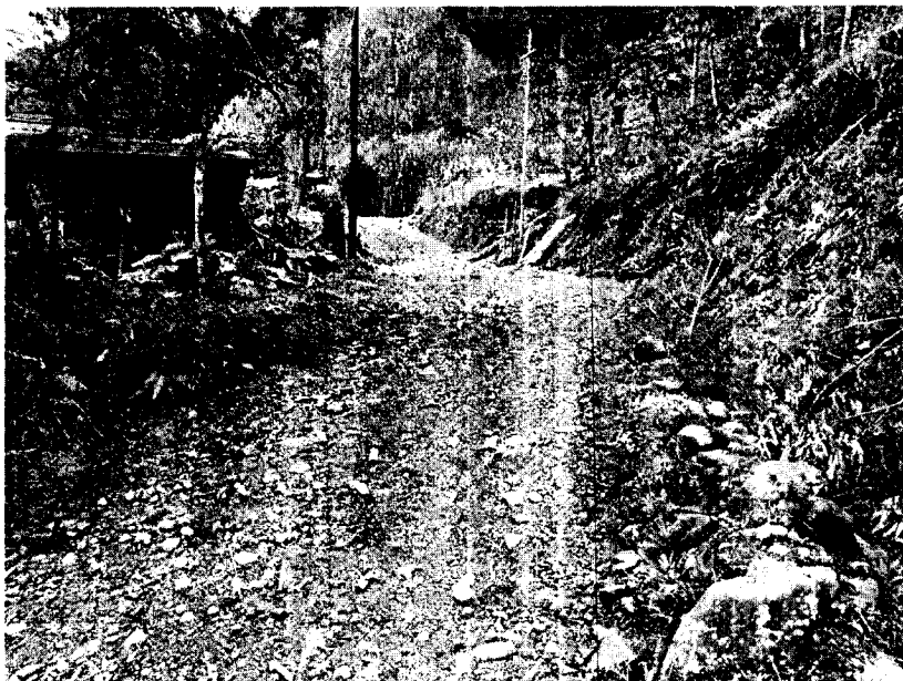
Estado actual del carreteable
